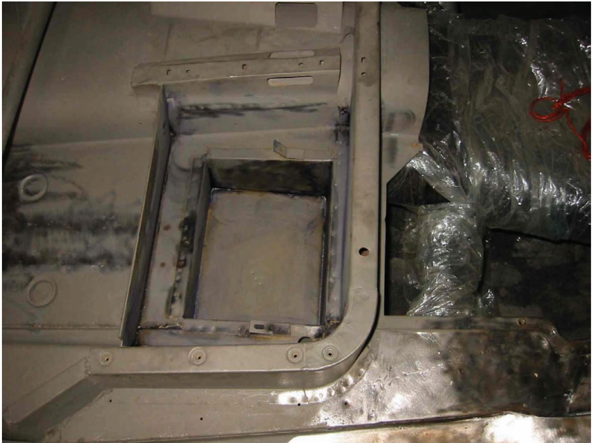
Die Blechenerarbeiten akkurat aber zeitaufwändig
